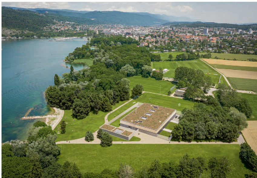
Bild 1: Neues Seewasserwerk Ipsach aus der Vogelperspektive
