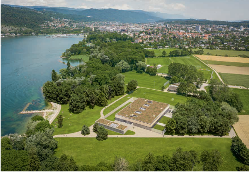
Bild 1: Neues Seewasserwerk Ipsach aus der Vogelperspektive
